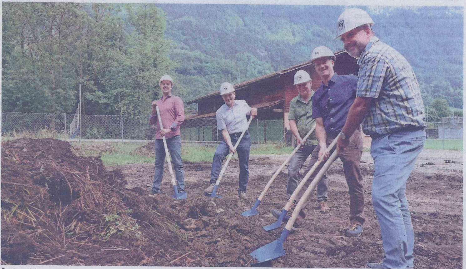
Spatenstich zum Neubau einer Heizzentrale im Wärmeverbund Ringgenberg (v.l.): Jürgen Weber (Projektleiter Triplex AG), Peter Aeschmann (Präsident Avari AG), Samuel Zurbuchen (Gemeindepräsident Ringgenberg), Martin Amacher (Mätzener & Wyss) und André Chevrolet (Gemeindeschreiber Ringgenberg). Foto: Bruno Petroni
