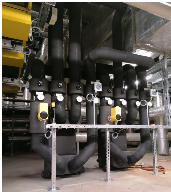
Abbildung 3: Systemtrennung ausgeführt
