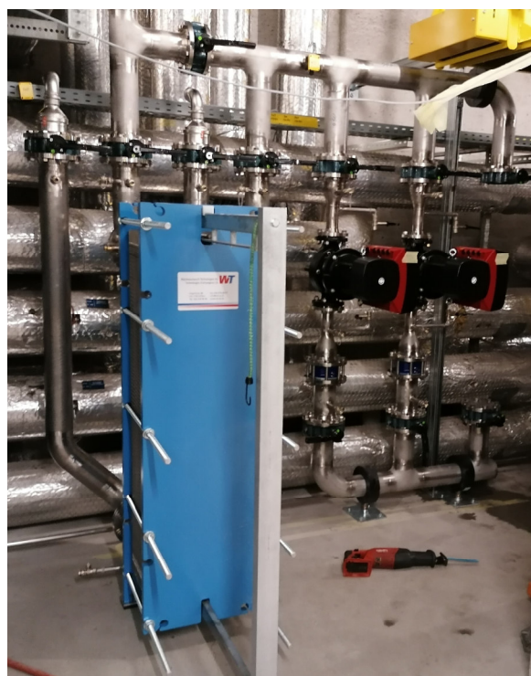
Abbildung 3: Systemtrennung ausgeführt
