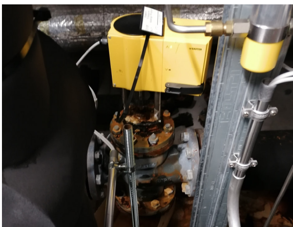
Abbildung 1: Korrosion Kälteventil
